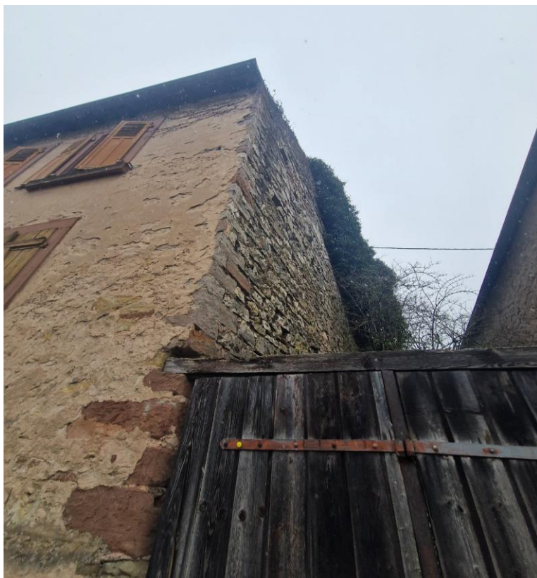
Seitenansicht mit Bewuchs im/am Mauerwerk
